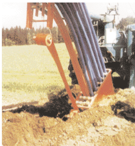
Rys. 5. Układanie wiązki przewodów [3].
