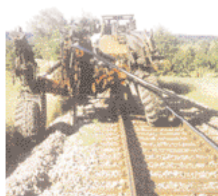
Rys. 8. Układanie sieci kablowych za pomocą pługu-układacza w nasypie kolejowym [2].
