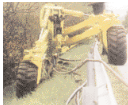
Rys. 7. Układanie sieci kablowych za pomocą pługu-układacza w poboczu drogi [2].
