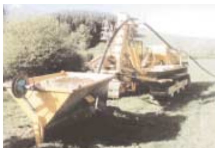
Rys. 6. Wbudowywanie sieci z jednoczesnym wykonywaniem obsypki piaskowej [4].
